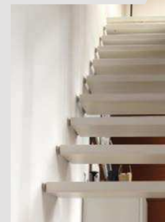
FIXATION DES MARCHES SUR MUR PORTEUR
