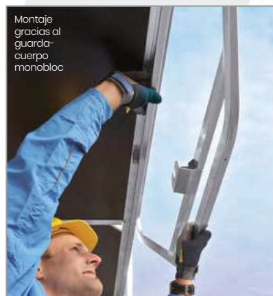
Sistema de conexión rápido para travesaños y Diagonals
